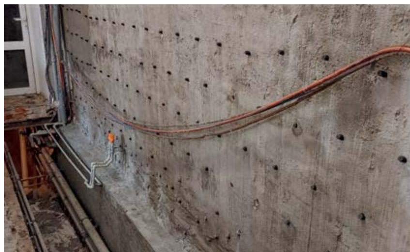
→ Prace remontowe w budynku przy ulicy Myśliwieckiej 8. Fot. Archiwum Arembud Renovation works in the building at 8 Myśliwiecka Street. Photo Arembud Archive
