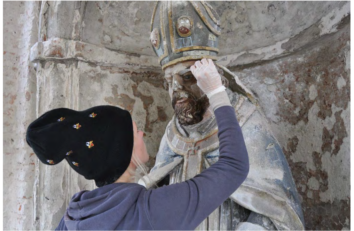
Prace przy elewacji kolegiaty św. Trójcy w Ołyce, Ukraina
